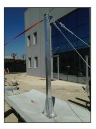
Dispositivo anticaduta temporaneo costituito da due pali in alluminio di altezza 2 m, controventati al trave a Y mediante utilizzo delle apposite piastre, uniti tra loro mediante linea vita provvisoria in cl. B.
